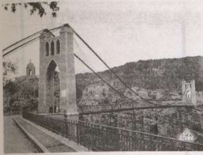
صورة تمثل جسر سيدي مسيد بقسنطينة
